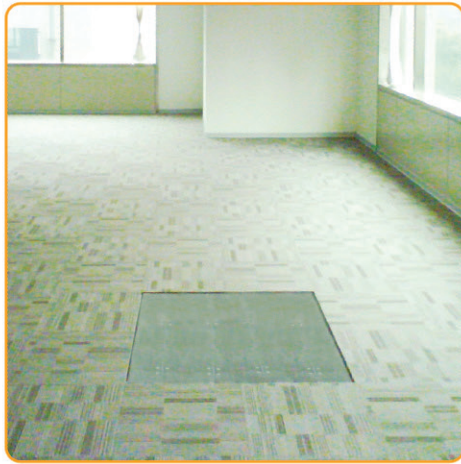
辦公大樓OA地板面貼方塊地毯實景
